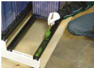
Fig. 5-13: traitement des rails d'installation
