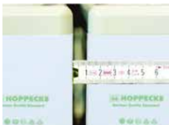
Fig. 5-14: écart de 10 mm entre les éléments de batterie
